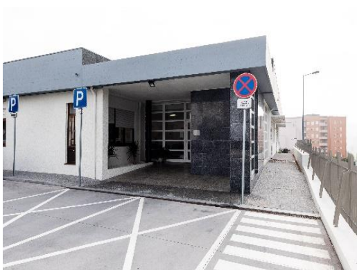
Centro Hemodiálise de Paredes
